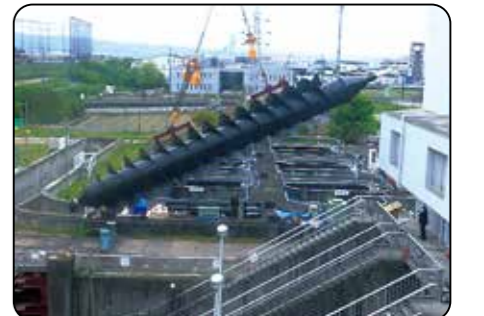
スクリーポンプの設置風景
