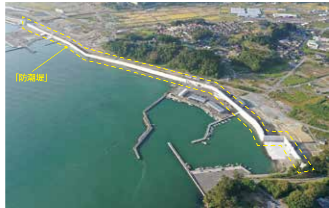
東日本大震災の津波被害にあった岩手県陸前高田市脇之沢漁港海岸に建設した防潮堤は、高さ12.5m・全長約2キロメートルにおよぶ大きさで、数十年から百数十年に1度の規模で発生すると予測されている津波から市内中心部を防災しています。(黄色の点線で囲んだ部分が「防潮堤」です。)
