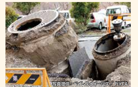
液状化によって飛び出したマンホール。重いビルや橋は沈み、軽いマンホールなどは浮き上がってくる。
