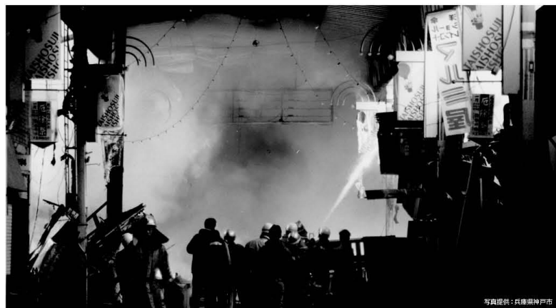
兵庫県南部地震（阪神・淡路大震災） 1995年1月17日午前5時46分発生 マグニチュード7.3の地震が神戸市等、阪神地域、淡路島を直撃。地震後約290件の火災が同時多発しました。数時間後から翌日以降にかけての火災は震度6以上の地域で多く、電気関係の火災が目撃されました。
