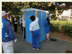
災害用トイレの組み立て。
