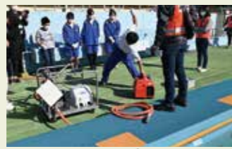
プールサイドでトイレ用水揚げポンプのエンジンをかけているところ。
